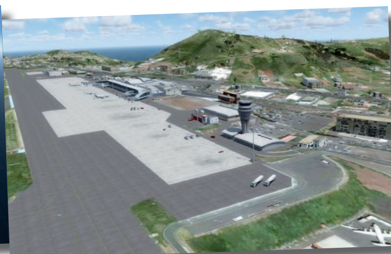
Apron, Tower und Terminal von Tenerife Norte in einfacher Umsetzung.
