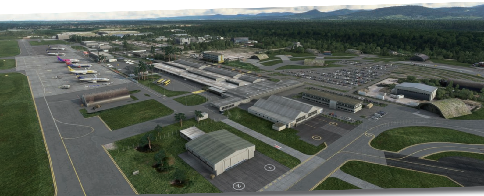
Im südlichen Teil des Flughafengeländes befinden sich (umgenutzte) Schutzbauten für Militärflugzeuge.
